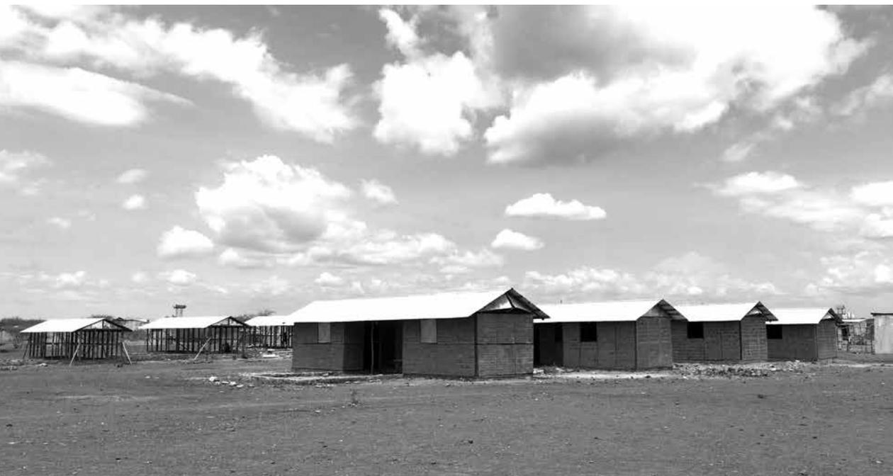
7 | Shigeru Ban, Philippe Monteil, Turkana Houses, Kalobeyei, Kenya, 2017. Il progetto è stato sperimentato in quattro tipi differenti: A. Struttura e pareti di tubi di cartone; B. Struttura di legno con pareti di mattoni di terra cotti; C. Pareti portanti di blocchi di terra compressa; D. Struttura di tubi di cartone e tamponatura in rami raccolti in natura. © Shigeru Ban.
