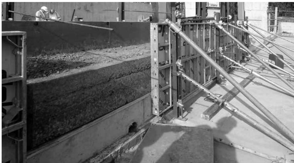
9 | Children's Surgical Hospital. Particolare del muro in costruzione, realizzato con la tecnica del *pisé*.
