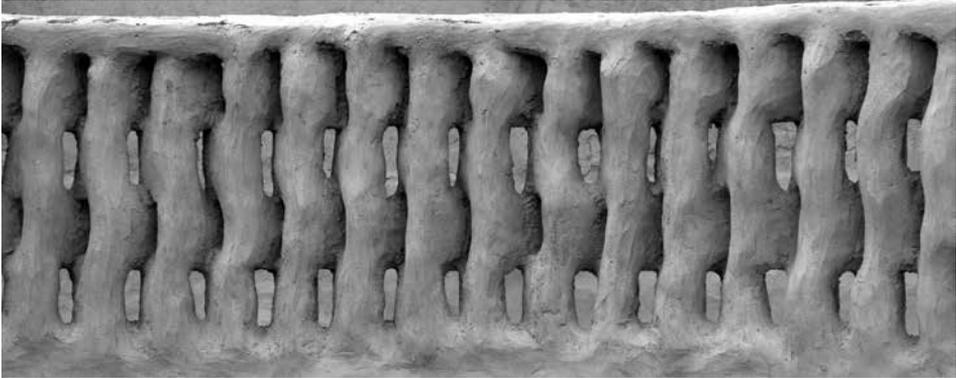
3 | Building Reality Workshop 2014. Dettaglio della parete in *adobe*, perforata e rivestita con intonaco di argilla.
