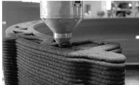
**6 |** Rapid Construction System for Concrete Houses. Il processo di stampa del prototipo per l'unità abitativa. © Xu Weiguo, Yipeng Liu.
