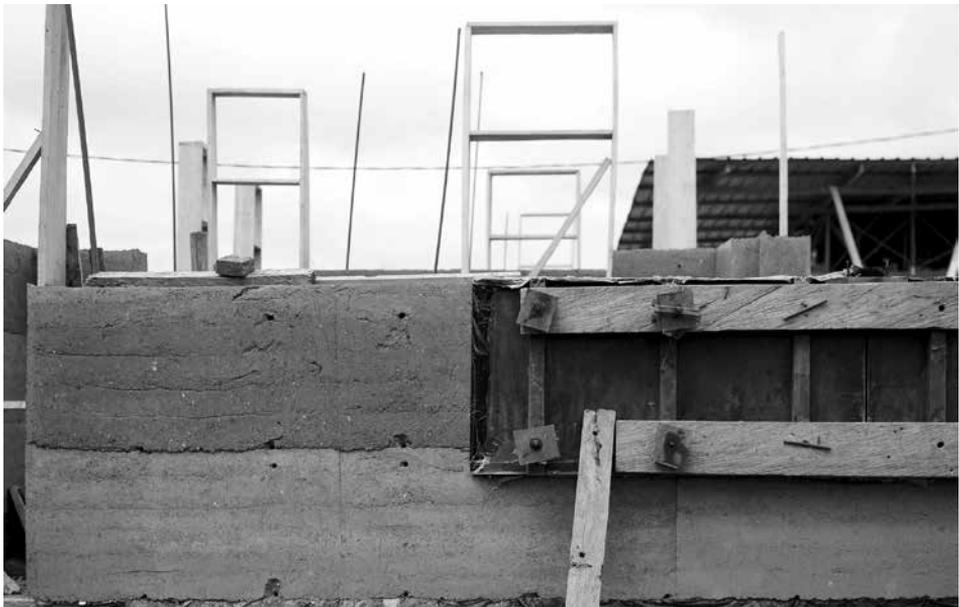
2 | eARTHouse. Schemi di assemblaggio delle casseforme modulari e il muro in terra durante la costruzione. Courtesy LOAD.
